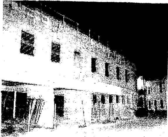
Il cantiere del Centro di supporto alle famiglie [ITALO ORRÙ]
